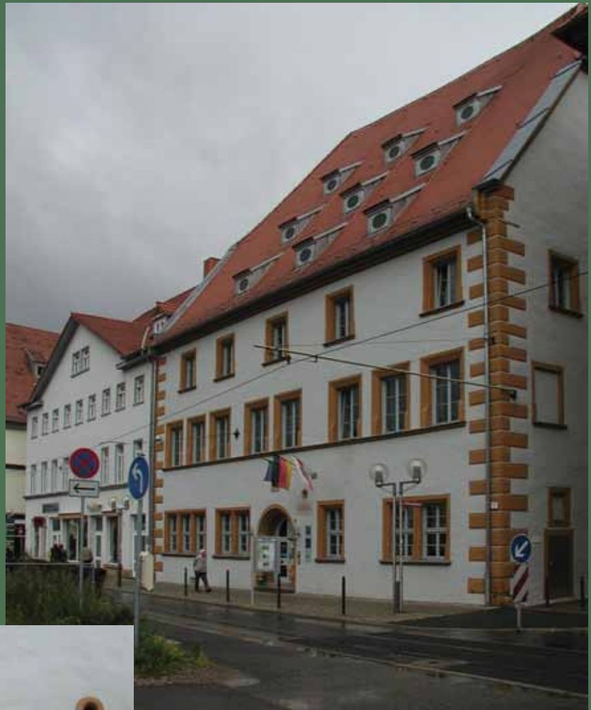
Abbn.: Das Geleitshaus Erfurt nach der Sanierung.
