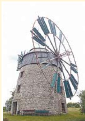
Unweit der Eckartsburg steht eine deutschlandweit einmalige Windmühle. Die 1830 erbaute „Holländerwindmühle“ besitzt anstelle von Flügeln ein zehnspeichiges Windrad. Was die Bauherren bewog, diese sonst im Mittelmeerraum verbreitete Konstruktion zu wählen, ist unbekannt. Die Windmühle wurde in den letzten Jahren wieder hergerichtet. Sie beherbergt ein kleines Museum. Außerdem wird Schäumahlen und Brotbacken angeboten (Anmeldung erforderlich).
