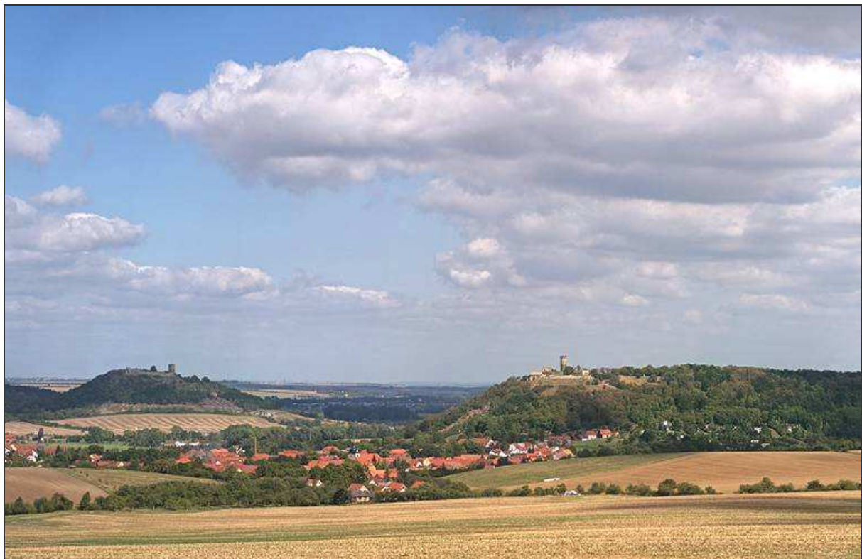
Abbildung 49: Die Burgen Drei Gleichen und Mühlburg Photo: www.fotocommunity.de
