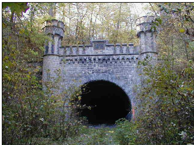
Abbildung 27: Westportal des Küllstedter Tunnels Quelle: www.vergessene-bahnen.de/Ex666_2.htm
