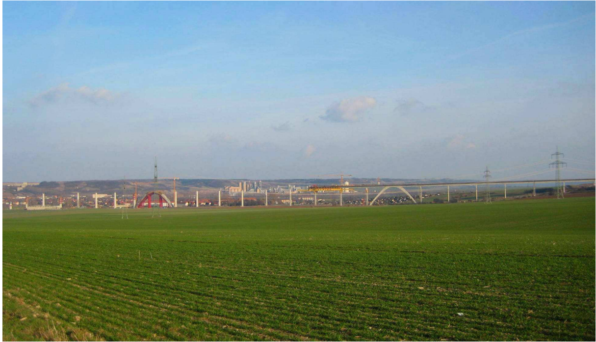
Abbildung 22: Bau der ICE-Strecke über die Unstruttalbrücke bei Karsdorf Photo: Margrit Contius 23.03.2010
